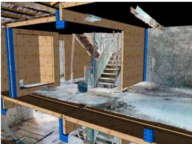
(12) (13) Proyecto de rehabilitación completa entre medianeras con paneles de CLT en Santiago de Coompostela. Arquitectos: ARROKABE Arquitectos. Escaneado nube puntos: GeoBim Solutions. Ingeniería: Escuadría.
