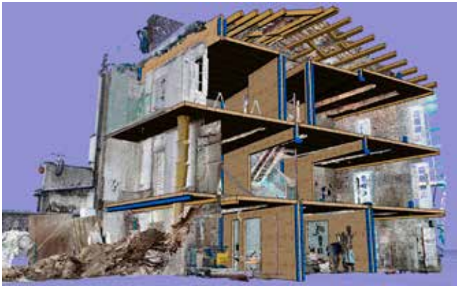
(14) Elaboración de planos de montaje para rehabilitación de la iglesia parroquial de Santa María en Villabrágima, Valladolid. Escaneado con el teléfono móvil e ingeniería: Orgánica Ingeniería en Madera.
